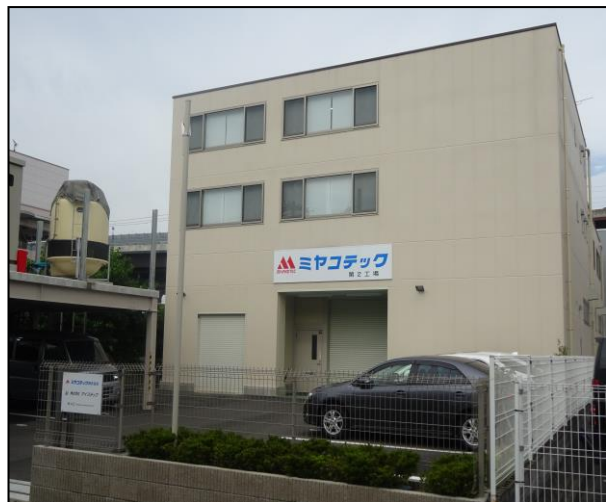
第二工場 外観
